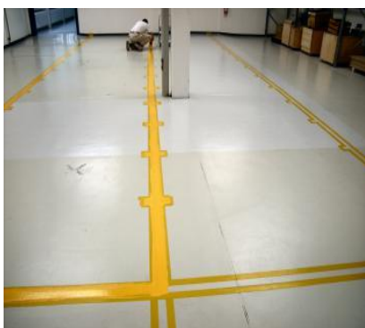
Mise en place de la peinture
