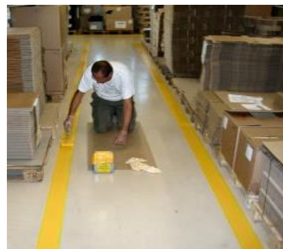
Mise en place de la peinture
